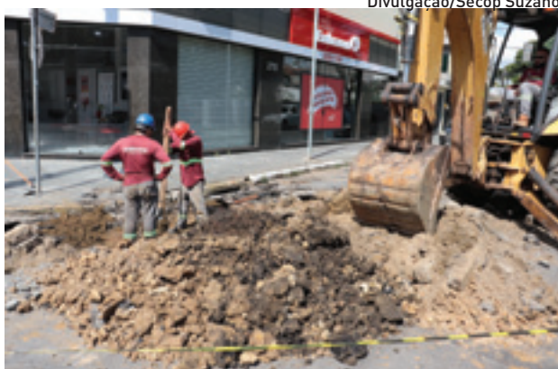
Via da região central também vai receber novo asfalto
