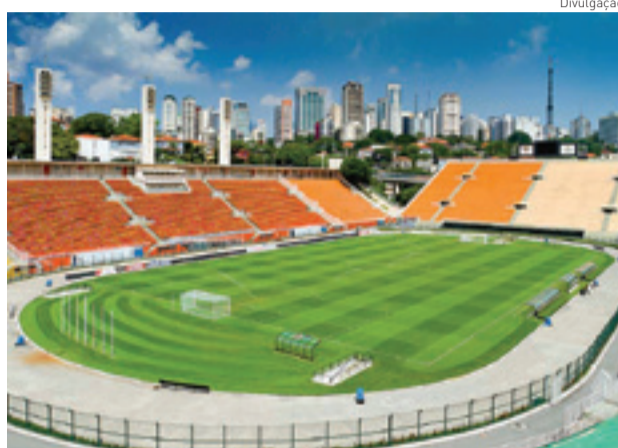
Gramado foi deteriorado após utilização para hospital
