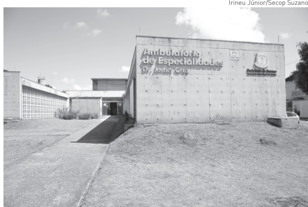
Estrutura funciona no Ambulatório de Especialidades
