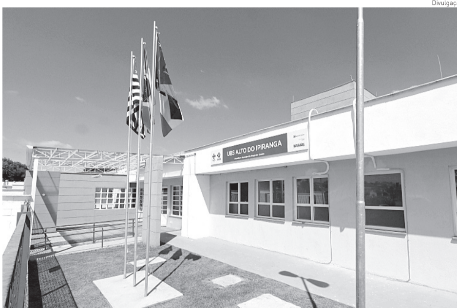
UBS Alto do Ipiranga foi último local danificado por ações realizadas por marginais
